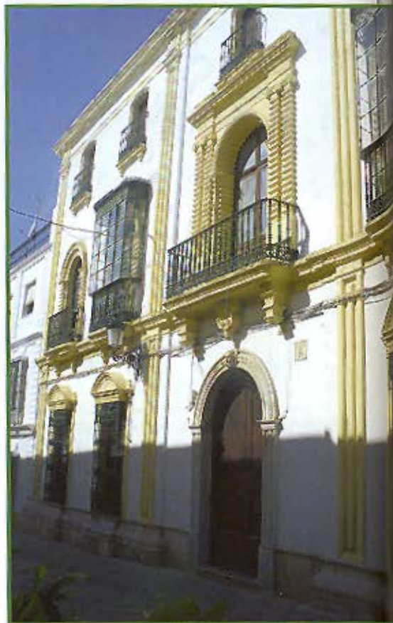
Palacio de Antonia Macides, en la calle del Santo nº 14, de Villamartín
